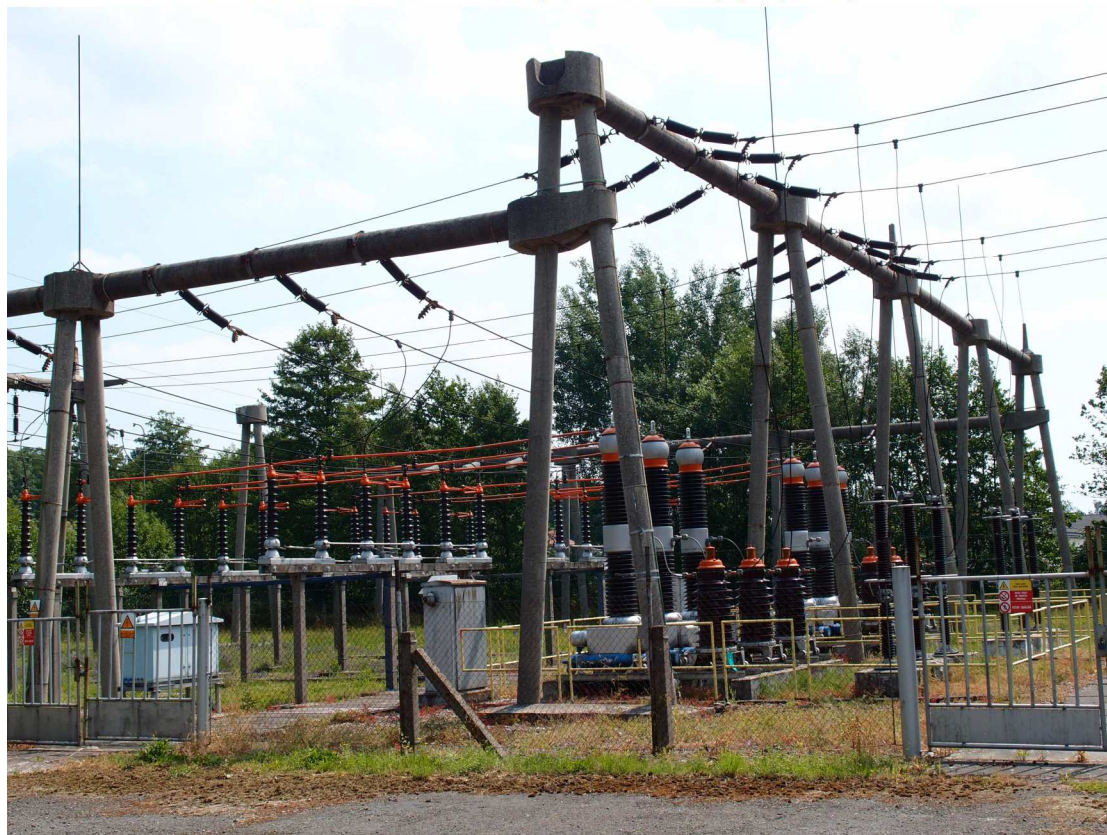
Obr. 7 Pole rozvodny 110 kV TNS Týniště n/O. s vypínači PTP za zábradlím pro základní ochranu zábranou a ovládací skříně s kabelový kanálem zakrytým panely
