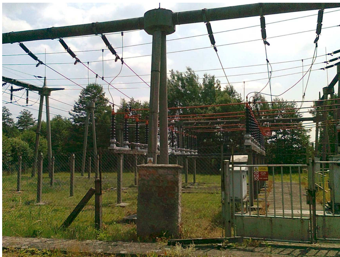
Obr. 4 Připojení odpojovačů 110 kV na „vysokých“ betonových stoličkách pro základní ochrana polohou ze systémů přípojníc A , B rozvodny 110 kV TNS Týniště n/O.
