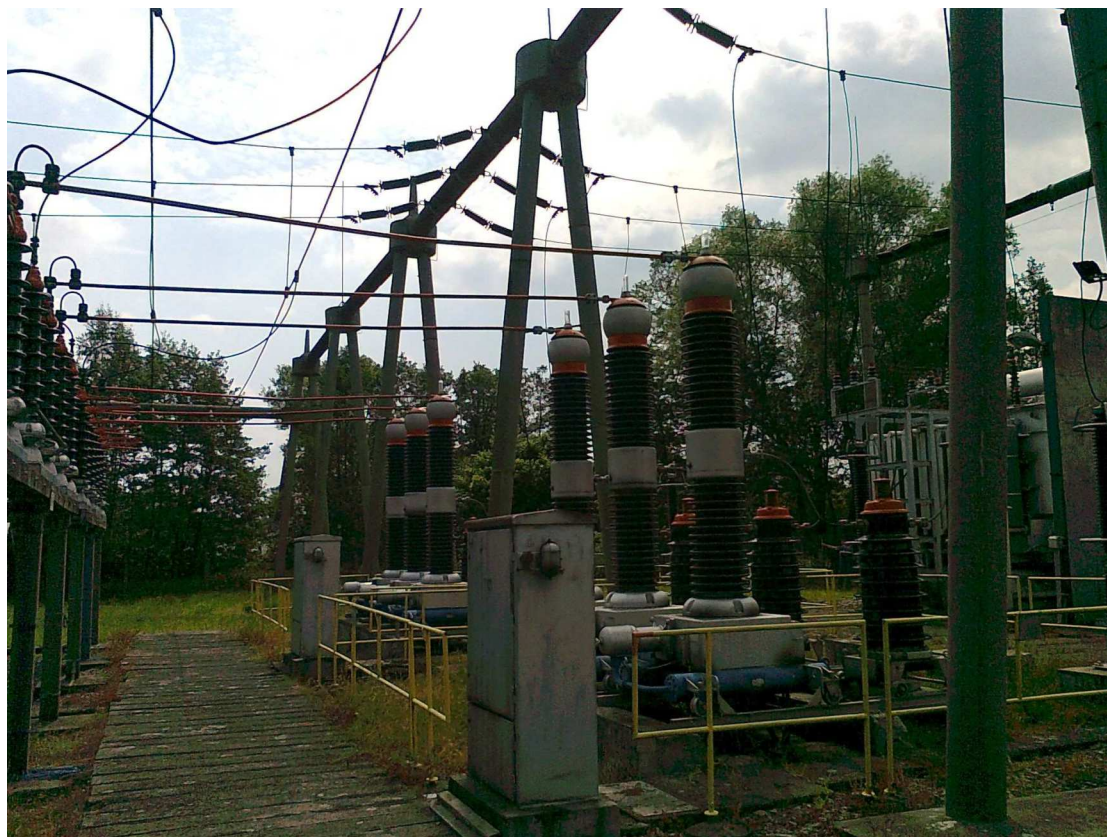
Obr. 7 Pole rozvodny 110 kV TNS Týniště n/O. s vypínači PTP za zábradlím pro základní ochranu zábranou a ovládací skříně s kabelový kanálem zakrytým panely
