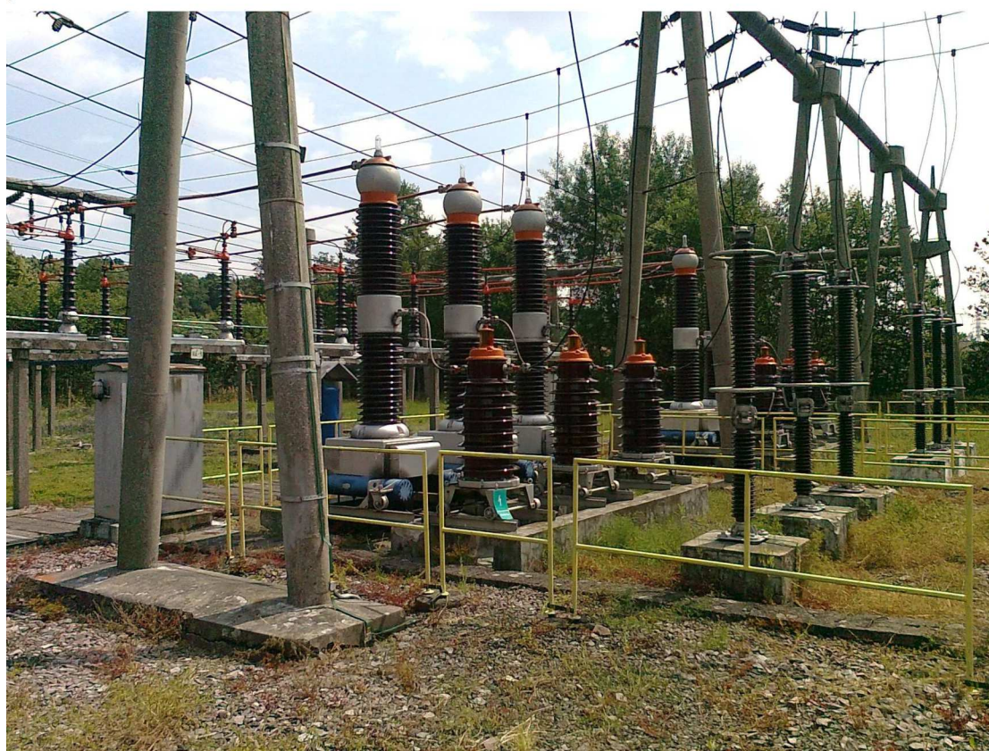
Obr. 6 Pole rozvodny 110 kV TNS Týniště n/O. s vypínači, PTP a bleskojistkami 110 kV za zábradlím pro základní ochranu (ochranu před neb. dotykem živých částí) zábranou
