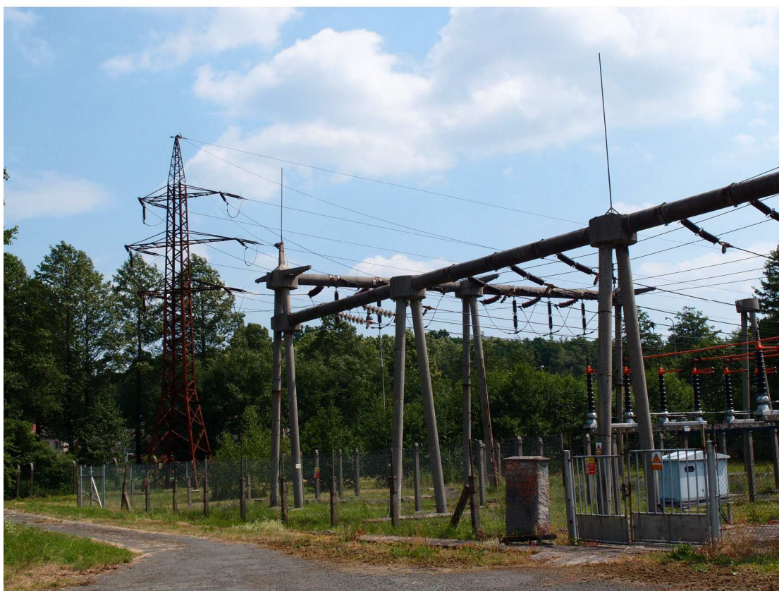
Obr. 1 Poslední stožár linek ČEZ-Di V1196 a V1195 zaústěných do rozvodny 110 kV SŽDC Týniště n/O.
